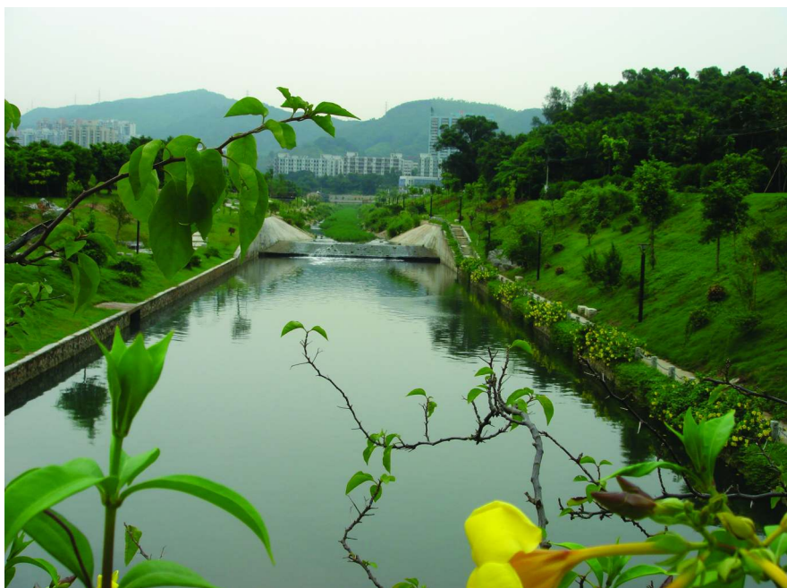
综合整治后的福田河
