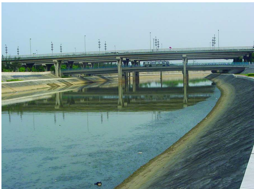
综合整治前的大沙河
