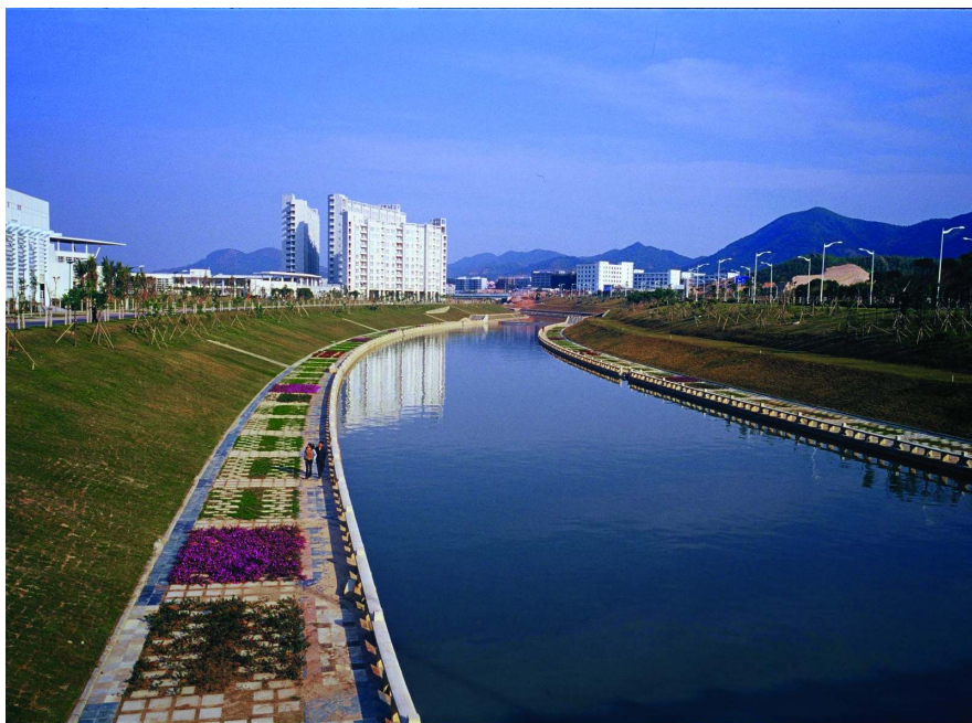
综合整治后的大沙河
