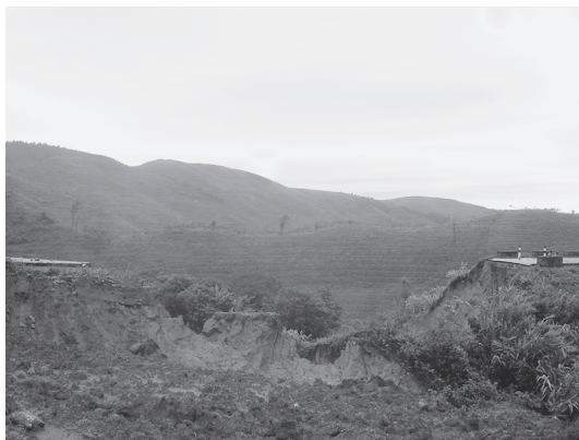
图 1-1 在雨季被雨水冲塌的西双版纳公路
