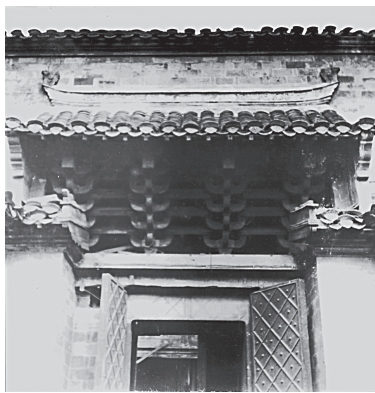
图1-3 拆迁前的六顺堂大门内门罩
